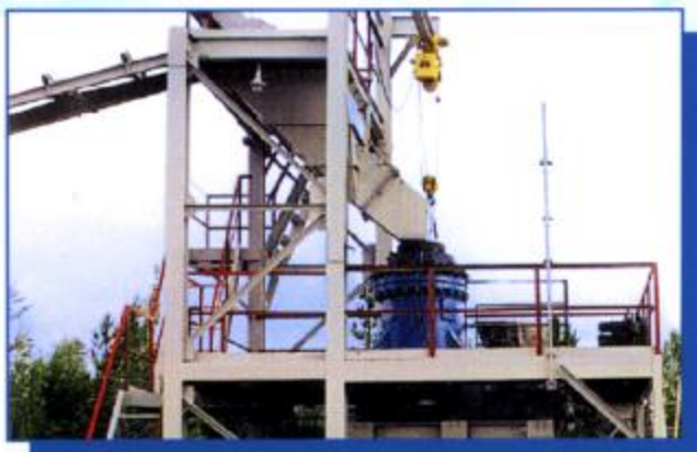
АБЗ СУ-8 «Лендорстрой-2», г. Санкт-Петербург. Установка на базе дробилки КИД-600
