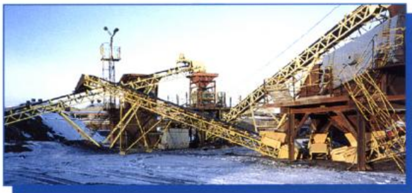
«Север», асфальтобетонный завод, Санкт-Петербург. Установка на базе дробилки КИД-900 .
